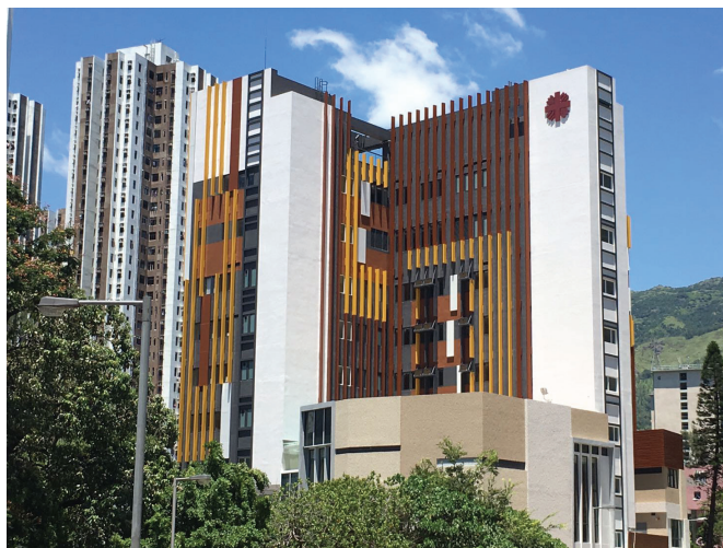
圖一：明愛荃灣社區中心重建後外觀
